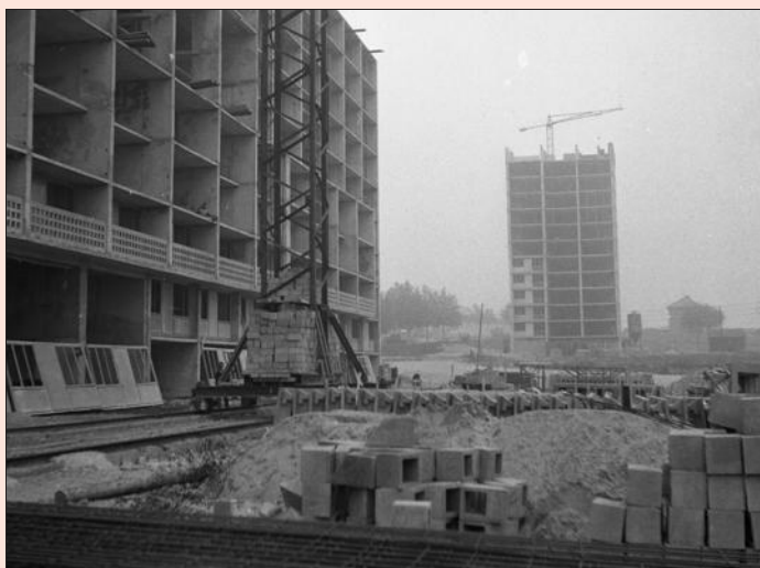
La construction de l'UC1 à Bron-Parilly date de la fin des années 50. Photo d'archives LE PROGRÈS
