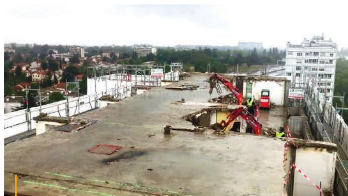
Ecrêtage du bâtiment par le haut
